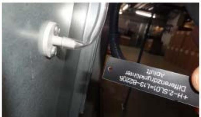
Knick in Luftschlauch zu Druckfühler einer Lüftungsanlage
