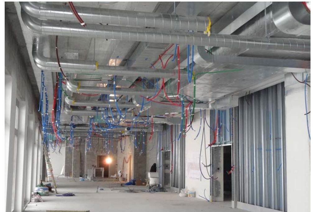
Lüftungsverteiler und Elektrohr kurz vor der Deckenmontage
