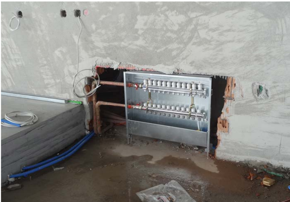
Heizverteiler vor der Einmauerung
