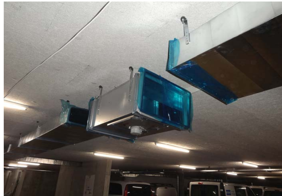
Lüftung - Schutz vor innerer Verschmutzung bei Montageunterbruch
