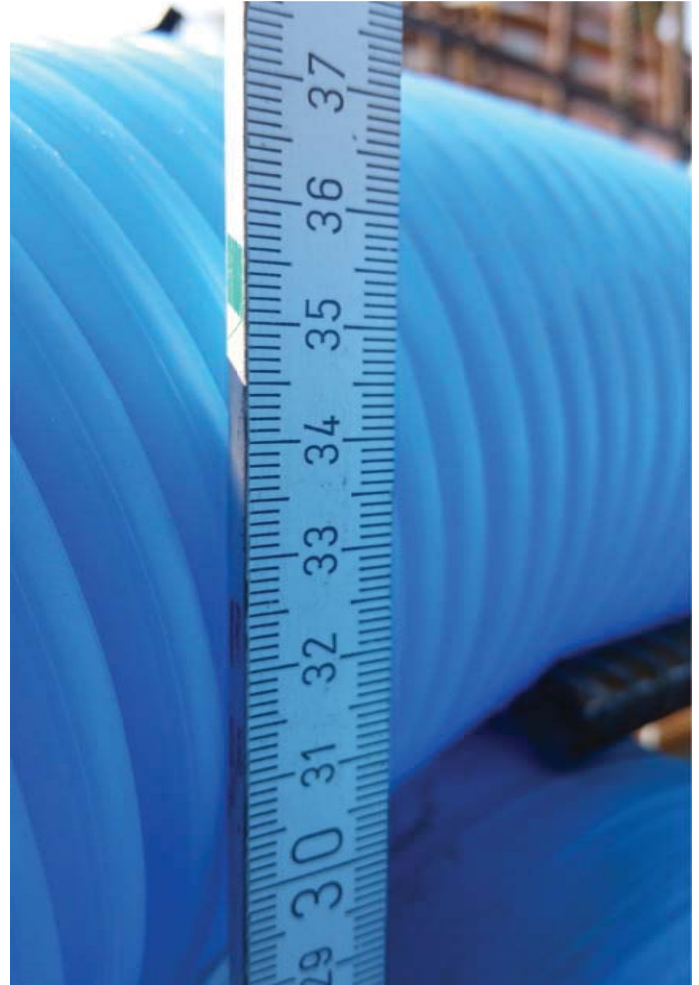
Lüftungseinlagen mit Kreuzung - zu hoch
