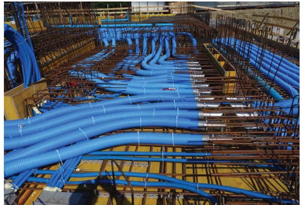
Lüftungsverteilerrohre in Betondecke - genügend befestigt
