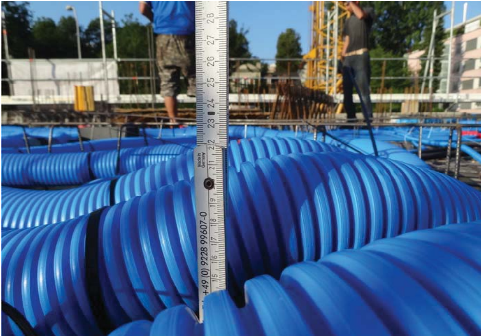
Korrekt ausgeführte Lüftungseinlagen
