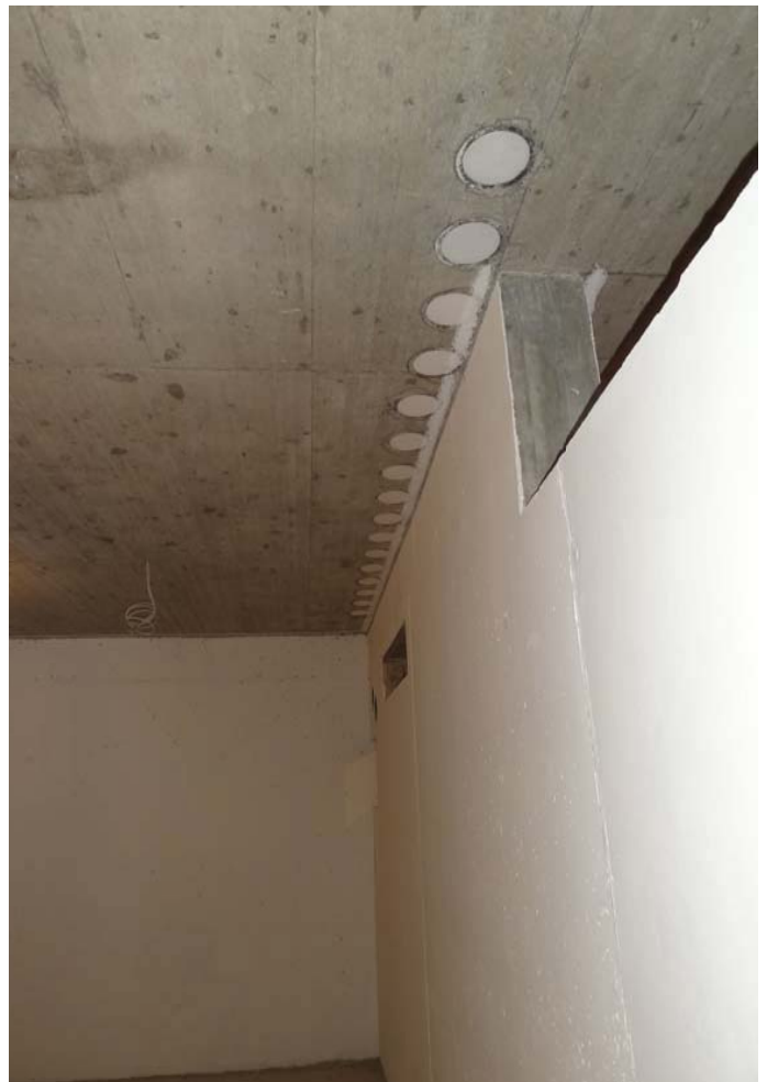
Eingelegte Lüftungsrohre mit prov. Deckel geschützt
