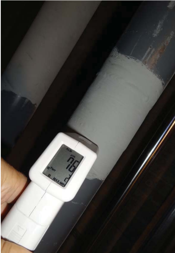
Schichtdickenmessung Kälte bei Schweissnaht
