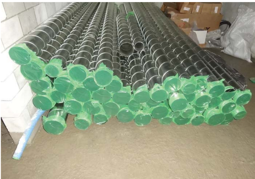
Gelagerte Lüftungsrohre vor innerer Verschmutzung geschützt
