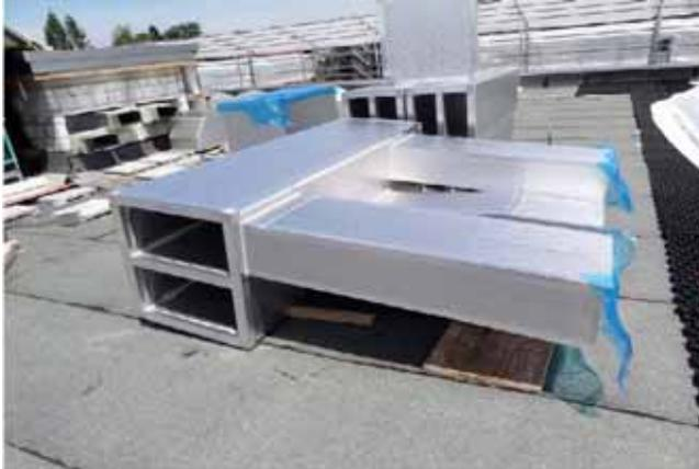
Doppelwandige isolierte Aluminium-Luftkanäle
