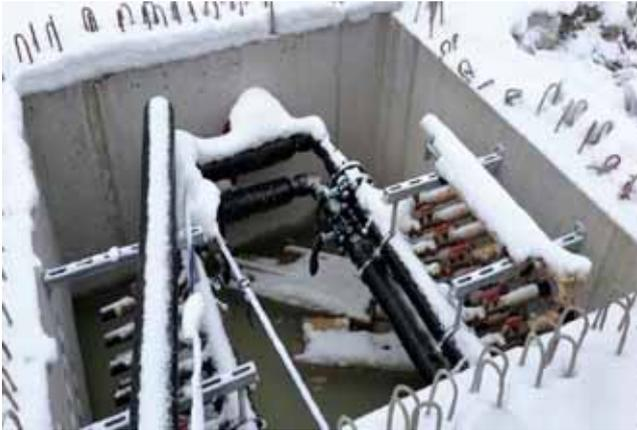
Erdsondenverteiler, Sammler mit Regelarmaturen
