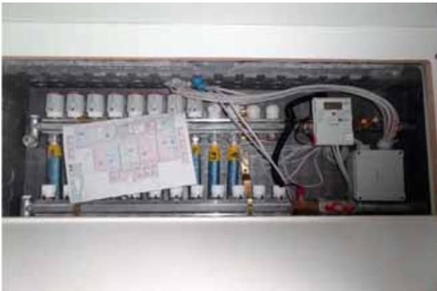
Wohnungsverteiler mit Wärmemessung und Regelventile
