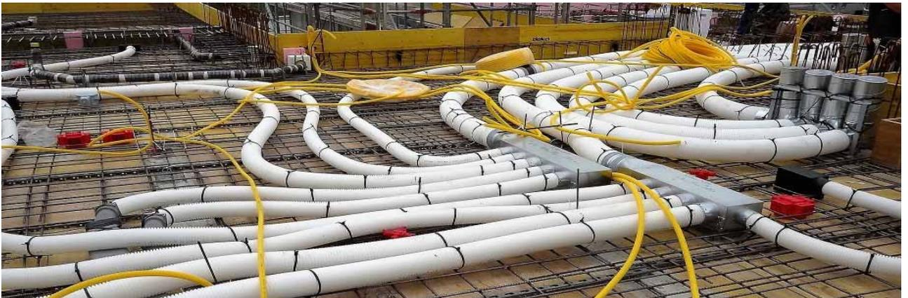
Lüftungsverteilung in Betondecke, Einlagen
