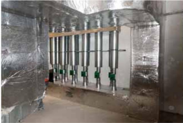
Lüftungsverteiler im Untergeschoss mit Luftmengenregulierung
