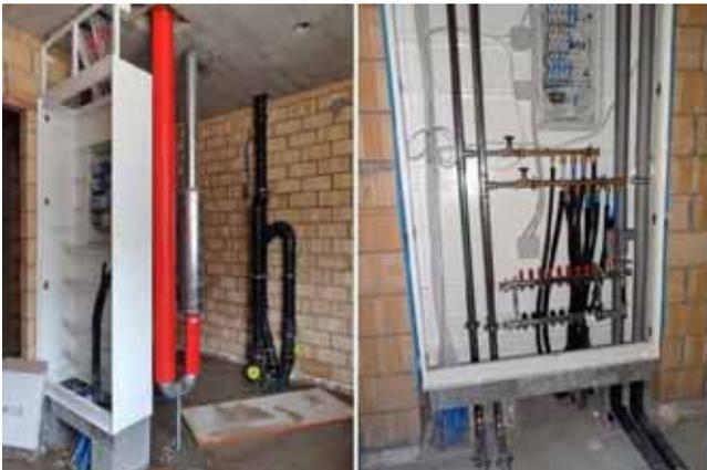
Kombinierte kompakte Wohnungsverteiler, Steigzone für Heizung, Sanitär und Elektro
