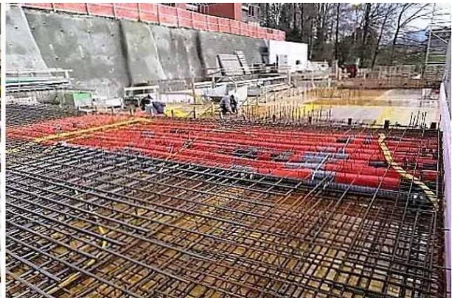
Lüftungseinlagen in Betondecke, Fortluft isoliert
