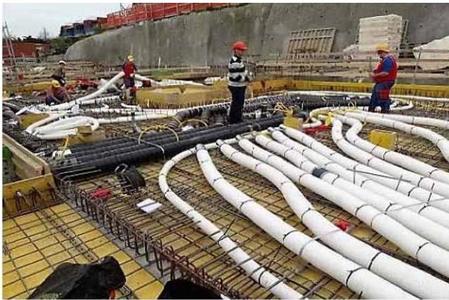
Lüftungsverteilung in Betondecke, Einlagen
