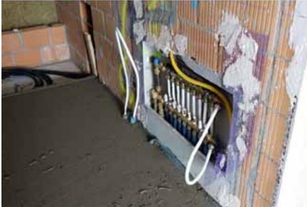
Bodenheizungsverteiler in Wand, Unterlagsboden eingebracht
