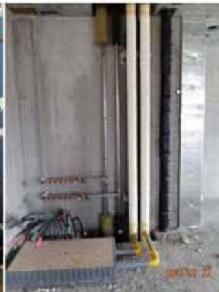
Steigstrang Heizung mit Verteiler; Wohnungslüftungsbox CO<sub>2</sub> reguliert
