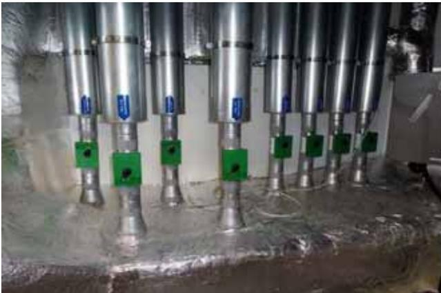
Lüftungsverteiler im Untergeschoss mit Luftmengenregulierung
