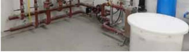
Heizverteiler, Wassererwärmung, Enthärtungsanlage
