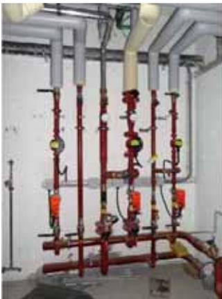
Heizverteiler, Wassererwärmung mittels externem Wärmetauscher
