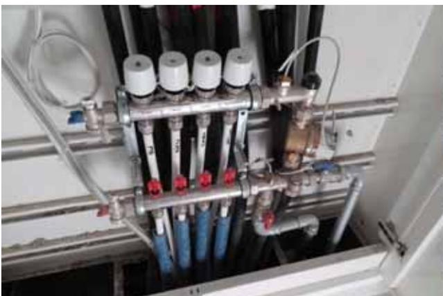
Wohnungs-Heizverteilkasten mit Regelventilen
