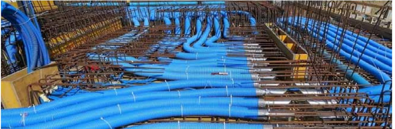
Recht massive Lüftungseinlagen vor Oberarmierung und Beton
