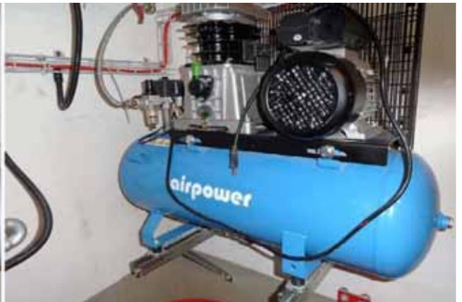
Druckluftkompressor für Trockensprinkler
