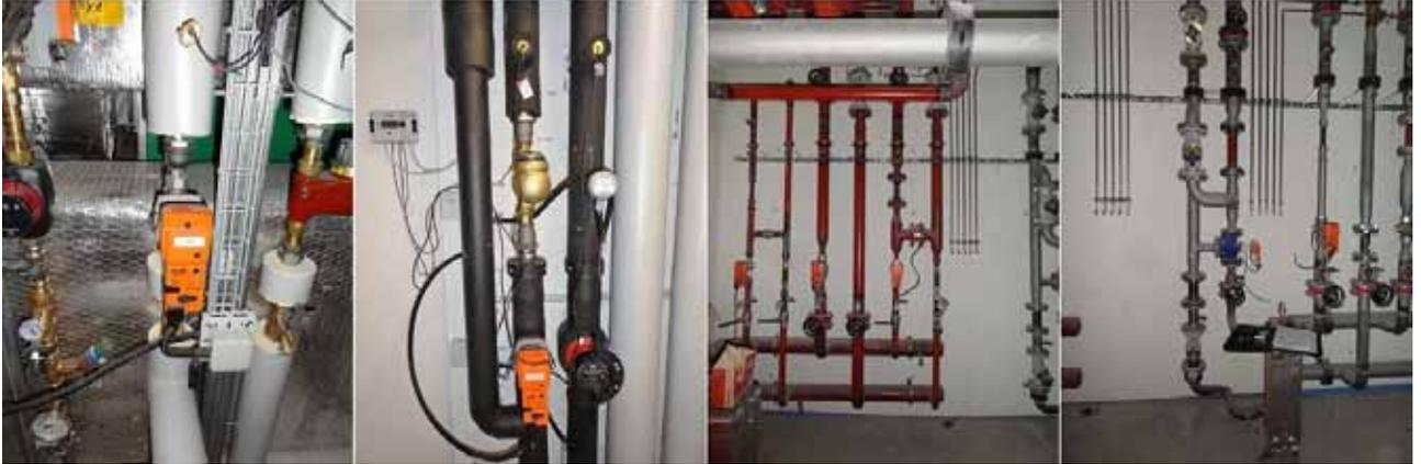
Verschiedene Verteiler Heizung und Kälte
