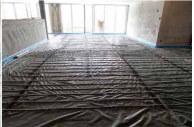
Fertige Verlegung der Bodenheizverrohrung, vor Unterlagsboden
