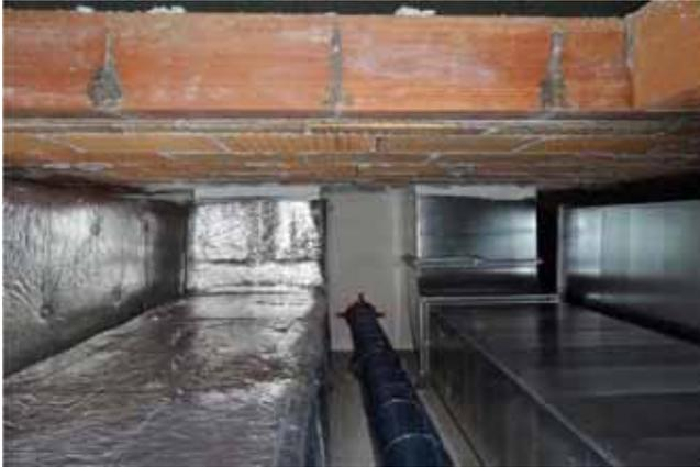
Zugängliche Steigzone mit Lüftungs-, Sanitär- und Kälteinstalltionen
