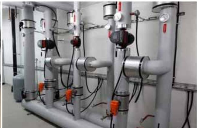
Heizverteiler, fertig gedämmt und beschriftet
