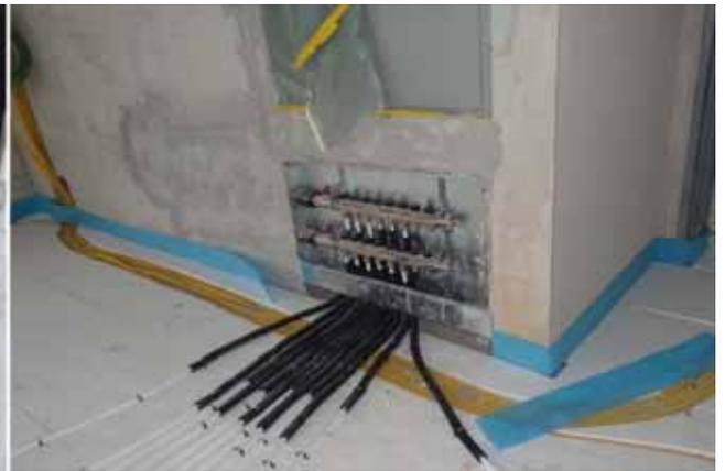
Heizverteiler mit Verteilrohren auf die Konvektoren
