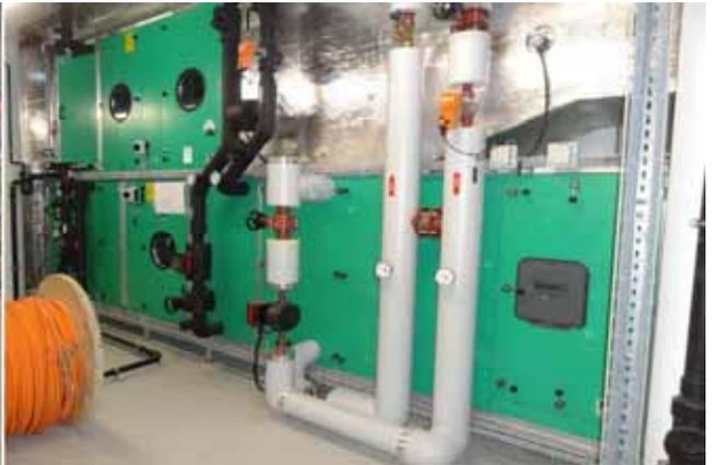
Luftaufbereitung fertig angeschlossen / verdrahtet
