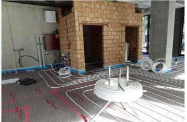
Verlegung der Bodenheizungsrohre in Arbeit
