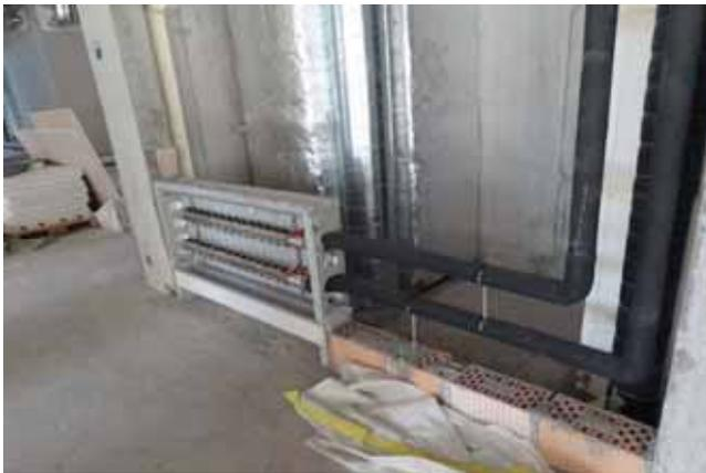
Heizverteiler mit Anschlussleitung
