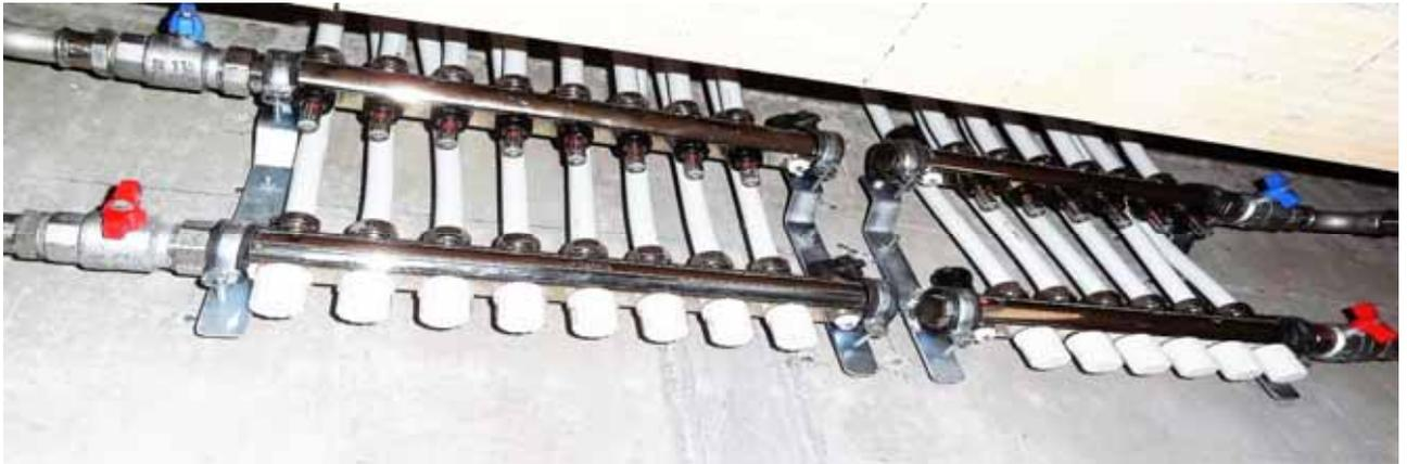
TABS-Verteiler mit Regelventilen
