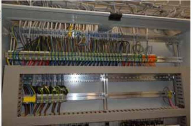
Schaltgerätekombination (Schaltschrank genannt) für die Steuerung der gebäudetechnischen Anlagen
