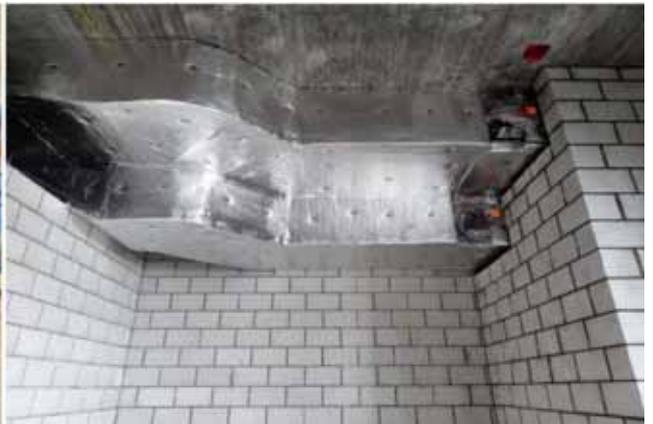
Lüftungssteigzone, gedämmte Kanäle, Brandschutzklappe
