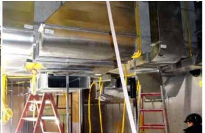
Lüftungskanal-Zwischenstück fehlt - Ausmassstück
