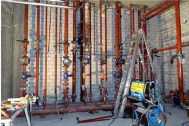
Heizverteiler für Raumheizung, Lufterwärmung und Warmwasser
