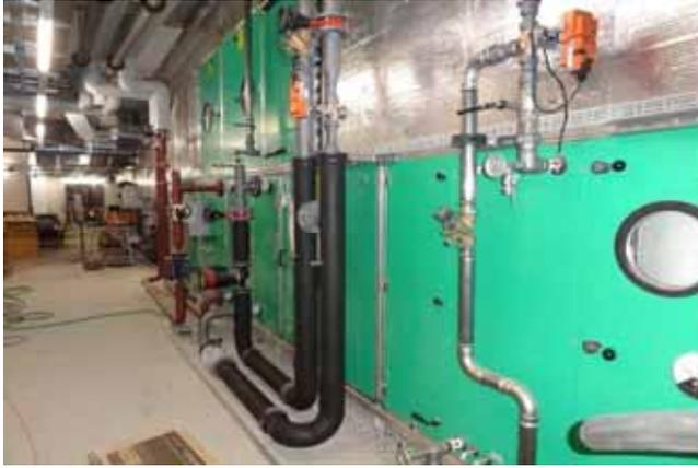
Luftaufbereitung (Monobloc grün) mit Wärmerückgewinnungs-, Heizungs- und Kälteanschlüssen
