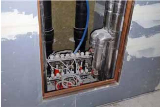
Zugängliche Steigzone für Heizung und Sanitär, Heizverteiler mit Regelventilen
