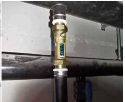
Durchflussregelorgan in Erdsondenverteiler
