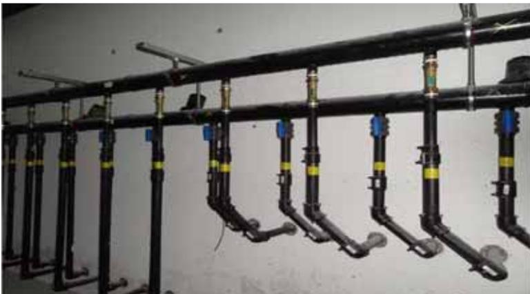
Einer der Erdsondenverteiler
