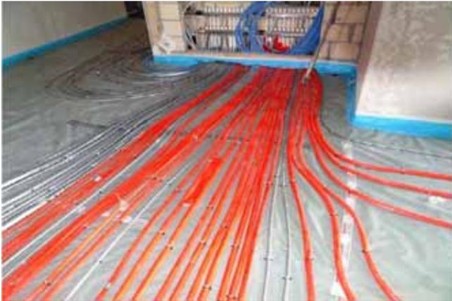
Verteilrohre zu anderen Räumen teils gedämmt, um Überhitzung zu vermeiden
