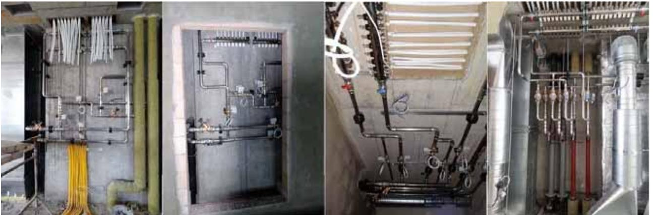
Steigzone und TABS-Anschlüsse an Decke
