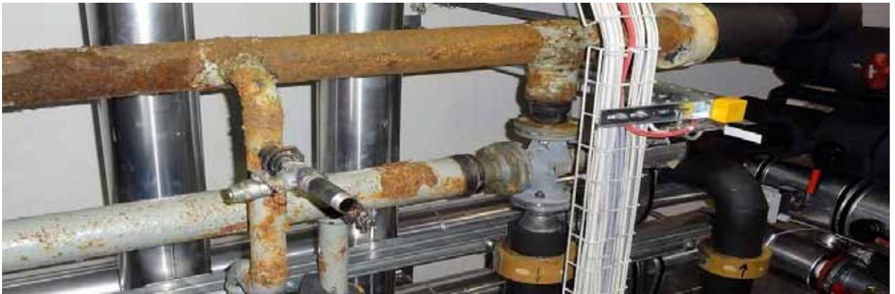
Umbau, Sanierung - bestehende ca. 20 jährige Kälteinstallationen partiell korrodiert
