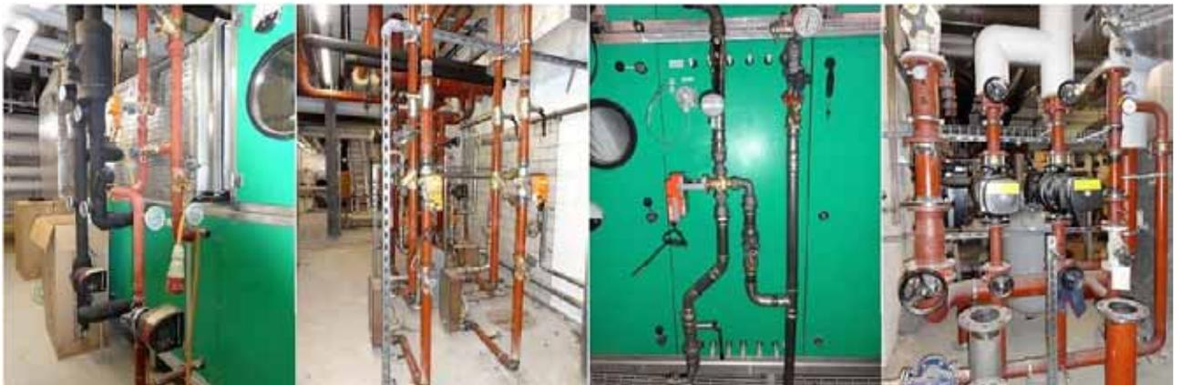
Grosse Lüftungsgeräte mit Heizungs- und Kälteanschlüsse
