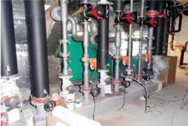
Kälteverteiler, unfertig gedämmt
