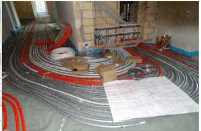
Verteilrohre zu anderen Räumen teils gedämmt, um Überhitzung zu vermeiden
