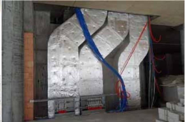
Lüftungssteigzone, gedämmte Kanäle
