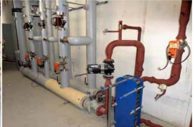
Heizverteiler mit Schnittstelle Mieterausbau
