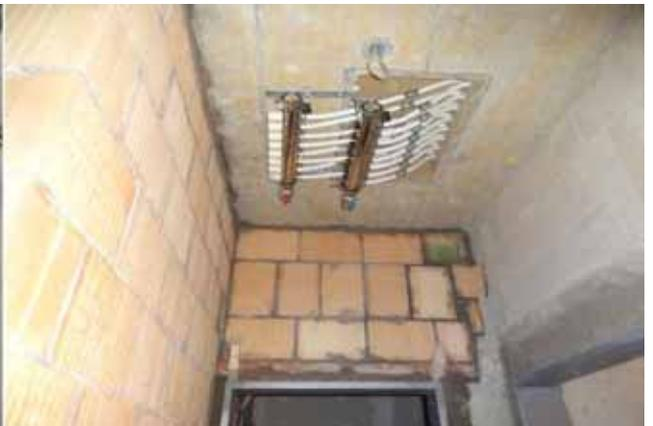
Wärme- und Kälteinstallation für TABS (Thermoaktives Bauteilsystem, über Decke heizen oder kühlen)
