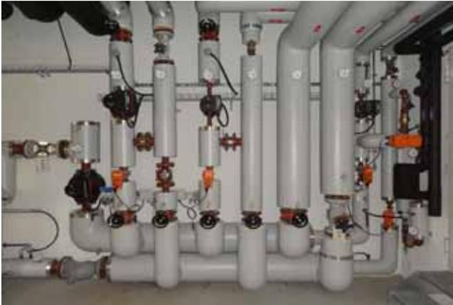
Heizverteiler, nahezu fertig gedämmt
