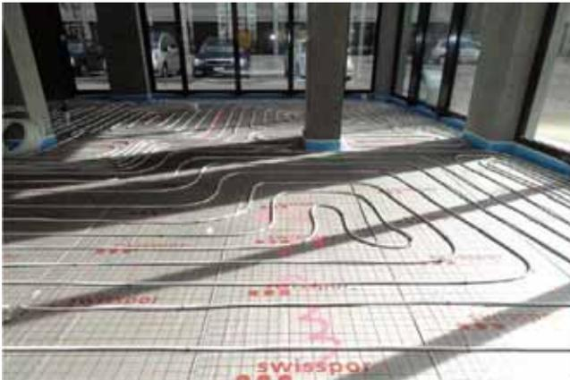
Fertige Verlegung der Bodenheizverrohrung, vor Unterlagsboden
