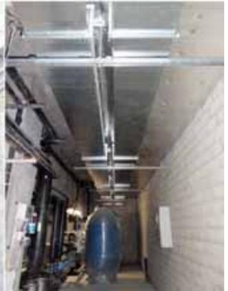
Isolierter Lüftungskanal mit Brandschutzklappen, div. Lüftungsinstallationen
